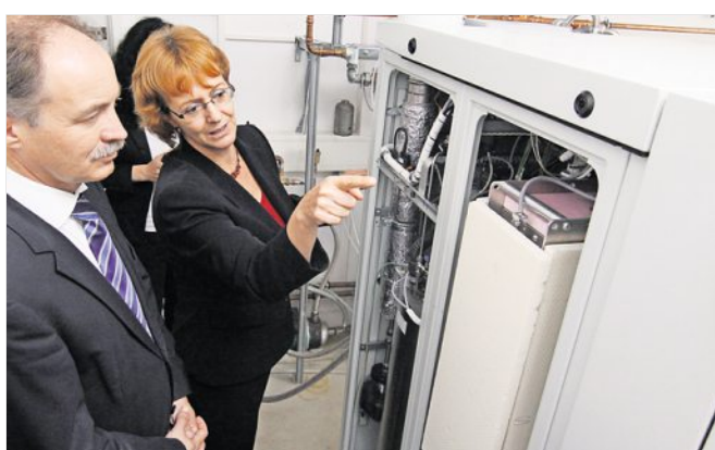
Dr. Kathrin Grosser, Geschäftsführerin der Riesaer Brennstoffzellen GmbH, zeigt Wirtschaftsminister Sven Morlok den „inhouse 5000+“, links ist der Reformator, rechts die Brennstoffzelle.
